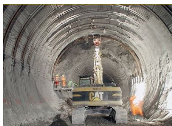
图1 铁路隧道(组合钢架)
